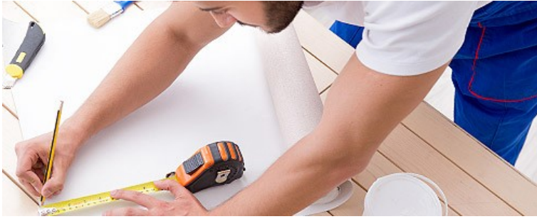
Строительные работы и ремонт помещений
